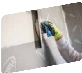
A hézagolóanyag szétterítése és elsimítása
