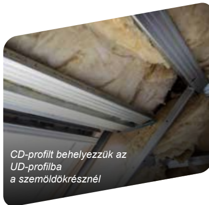
Alapszerkezet szerelése, az UD- és CD-profilok összecsavarozása Opel csavarokkal
