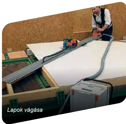
A kisebb bevágásokat készíthetjük kézfűrészsel is.
