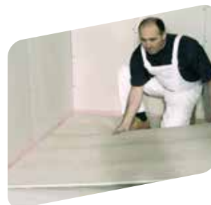
A második lapréteg elhelyezése
