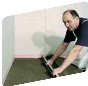
Rigidur® szárazkiegyenlítő egyengetése
