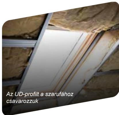
CD-profilt behelyezzük az UD-profilba a szemöldökrésznél
